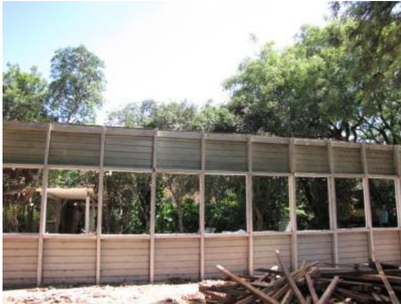
Fotografia da Demolição
